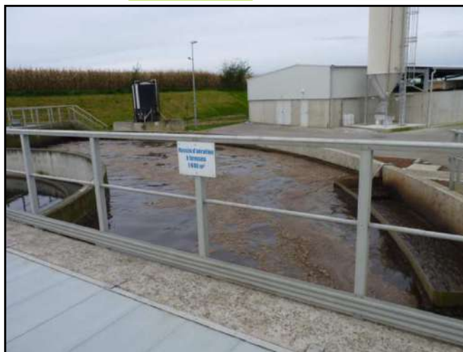
Photo 2: Station d'épuration de Rosières-en-Santerre (novembre 2013)
